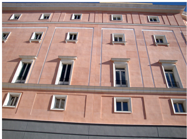
Figura 17. Aspecto de la fachada una vez terminadas las obras (febrero 2014).
