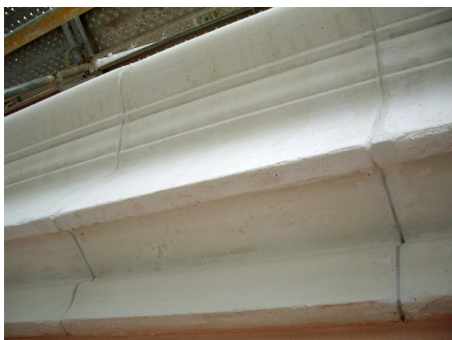
Figura 12. Juntas de cornisa superior.
