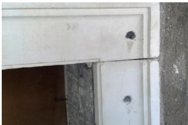
Figura 10. Ejecución de reanclado de emboadura de ventana.
