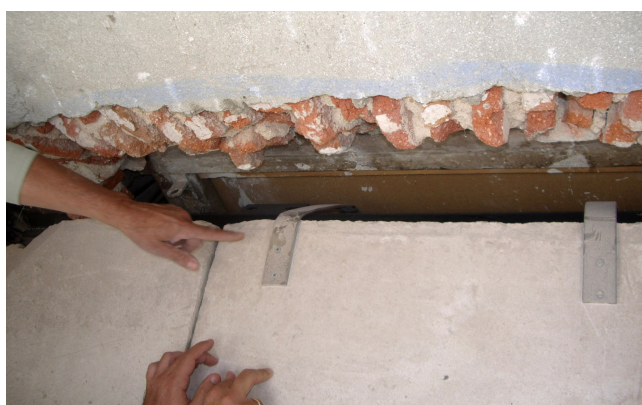
Figura 11. Piezas del guardapolvo reancladas con pletinas de acero inoxidable.
