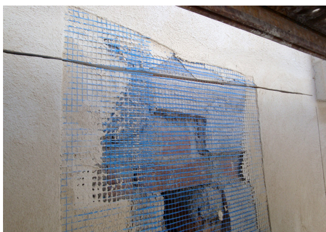
Figura 14. Malla de armado de la capa base.
