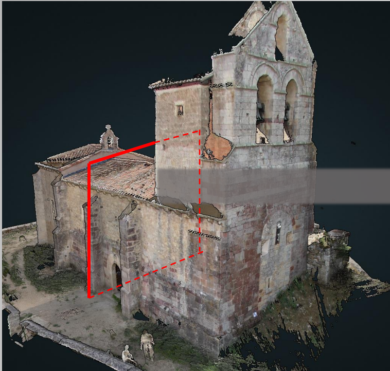
Replica digital de una Iglesia románica con problemas estructurales
