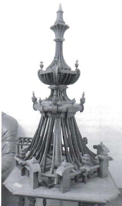
Figura 3 Maqueta de la armadura del chapitel (imagen de los autores).
