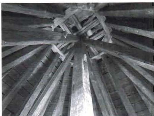
Figura 6 Imagen del interior del cuerpo bajo y del entramado horizontal inferior de la cornisa, a modo de almizate (imagen de los autores).
