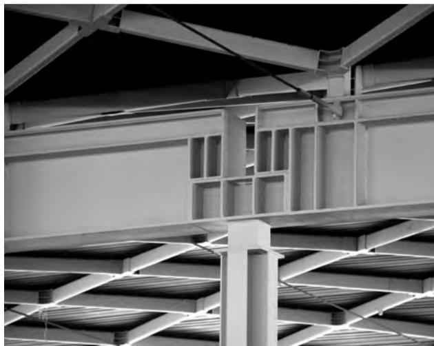
▼ FIG. 2. Obra en construcción
