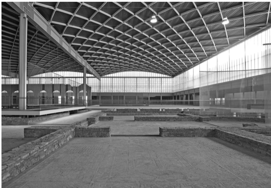
▲ FIG. 1. Obra acabada. © LAsin
