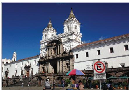
Mortero de cal sobre fachada Iglesia San Francisco
