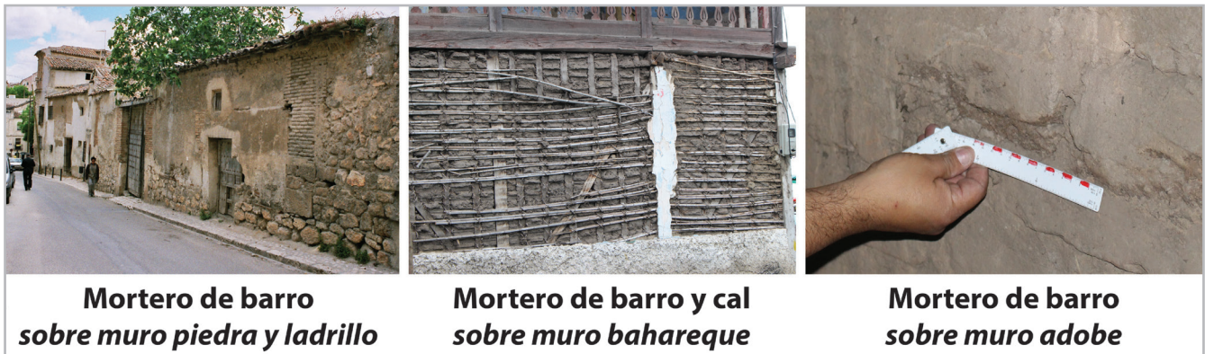
Figura 4.- Revestimientos de barro
