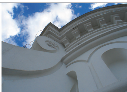
Mortero de cal en cúpula de Catedral Quito
